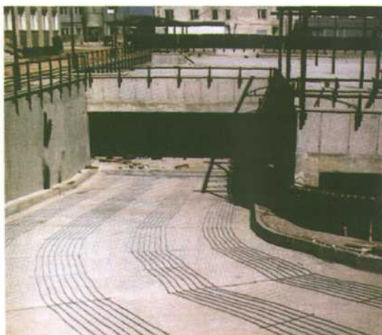
Montaż kabli grzewczych na podjeździe
