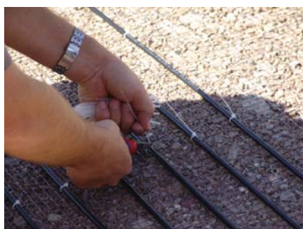
Rys. 3. Wjazd do garażu – sposób ułożenia przewodów
